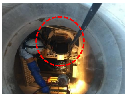
中間スラブに設置
