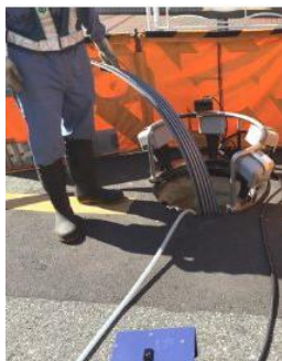
管更生材搬入
