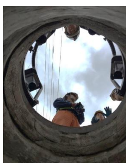
地下からの目視確認
